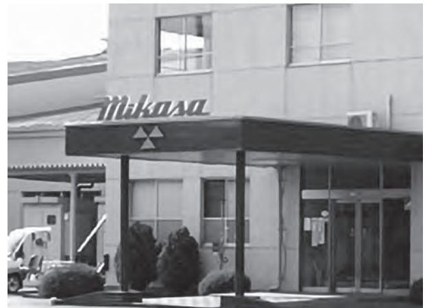
館林工場外観
