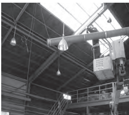
【工場内ダクト工事】
