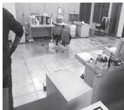
【事務所内床工事】
